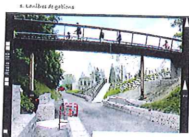
1. Lanibres de gabions
