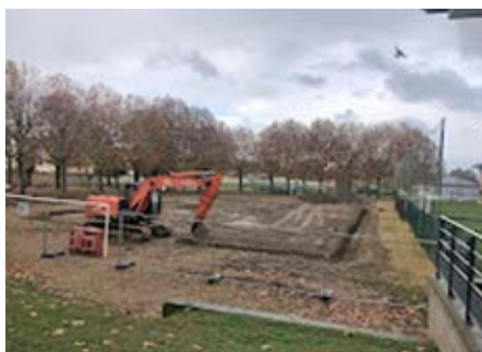
Travaux du « Foot 5 »
