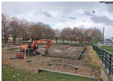
Travaux du « Foot 5 »
