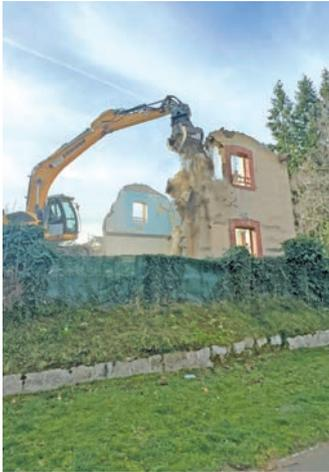
Les travaux ont débuté en mars par la démolition du bâtiment. Une opération menée avec attention par l'entreprise Moulin TP, spécialisée dans la déconstruction de ce type de bâtis. Ce chantier a permis le tri et le recyclage de tous les matériaux, conformément aux exigences environnementales.
